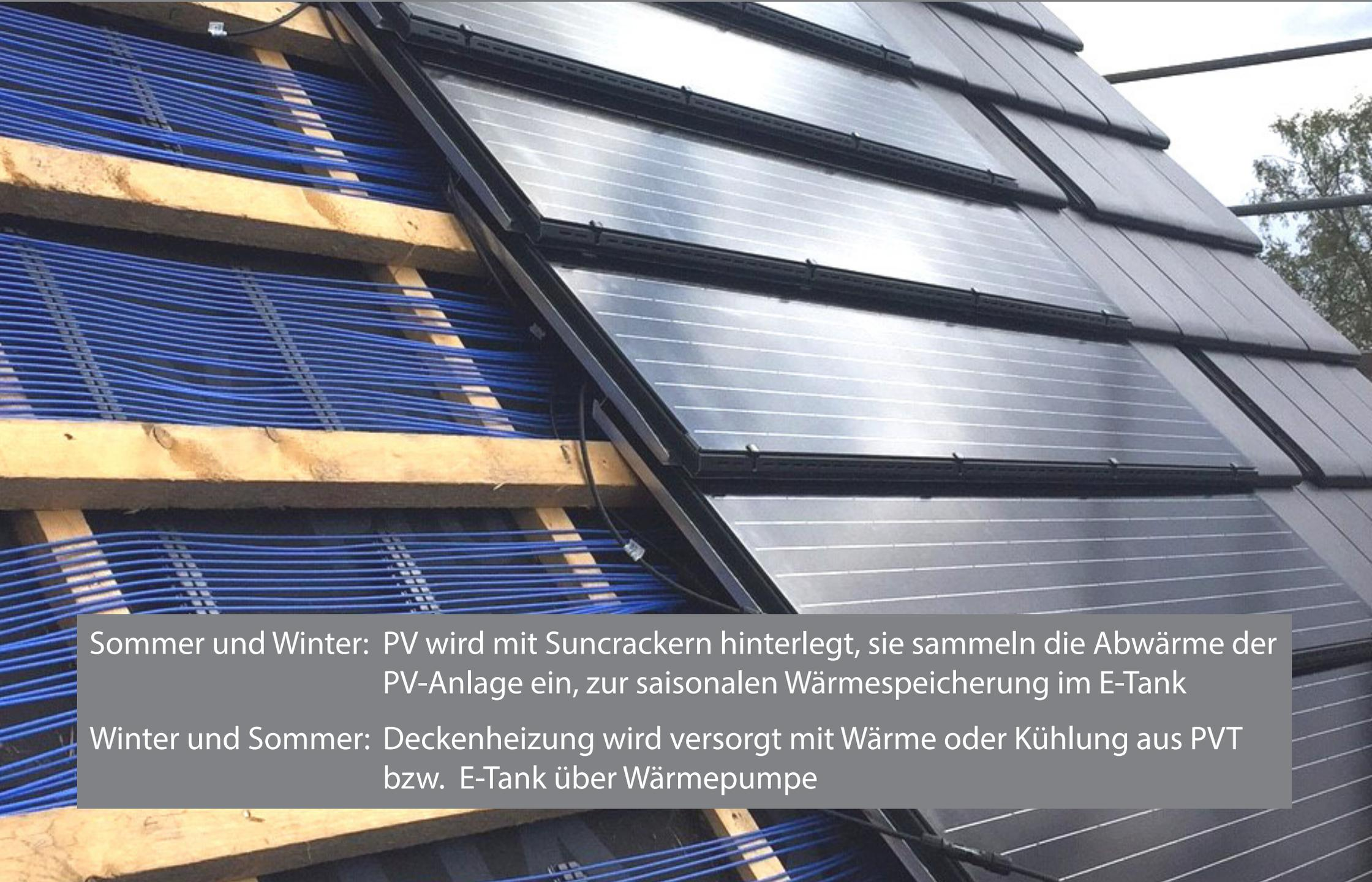
Sommer und Winter: PV wird mit Suncrackern hinterlegt, sie sammeln die Abwärme der PV-Anlage ein, zur saisonalen Wärmespeicherung im E-Tank
