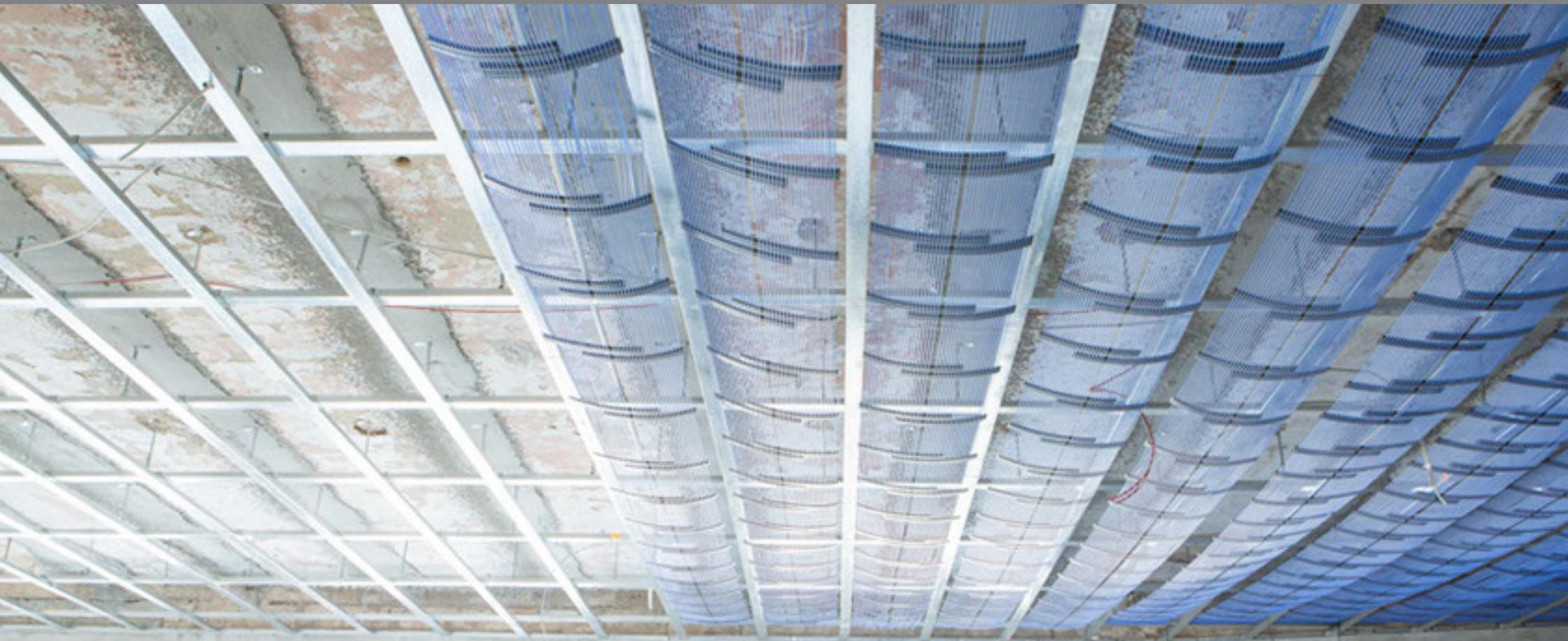
Sommer : Kühldecke sammelt Prozess-Abwärme ein, die im e-Tank gespeichert wird
